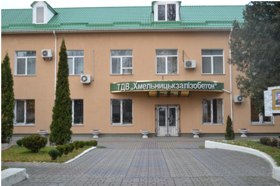
Фото: офіційний сайт ТДВ "Хмельницькзалізобетон"
