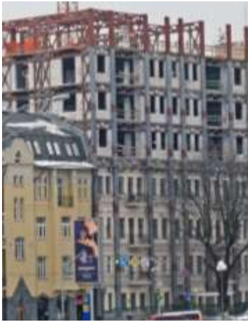
Рис. 1. Загальний вигляд каркасу надбудови
