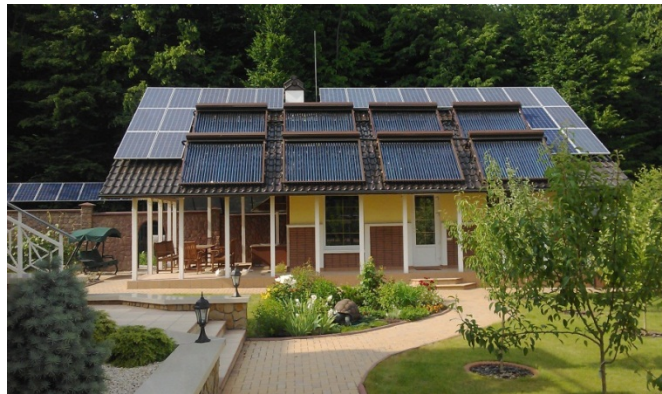
Рис. 3. Сонячна електростанція потужністю 10 кВт (Хмельницька область)
