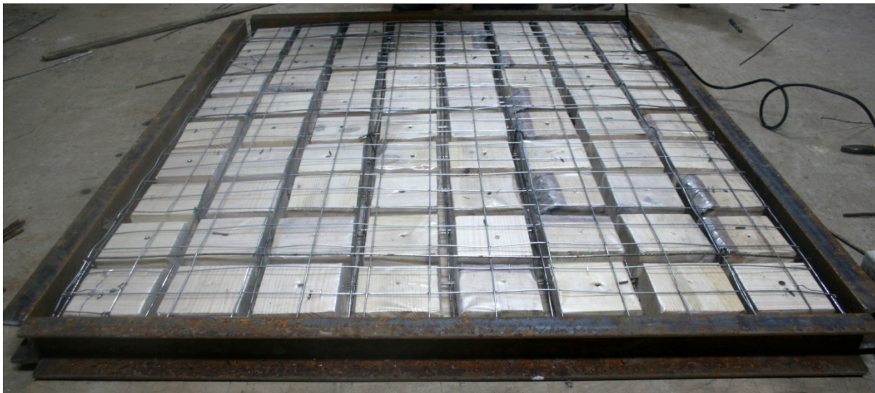
Рис. 2. Устройство опалубки
