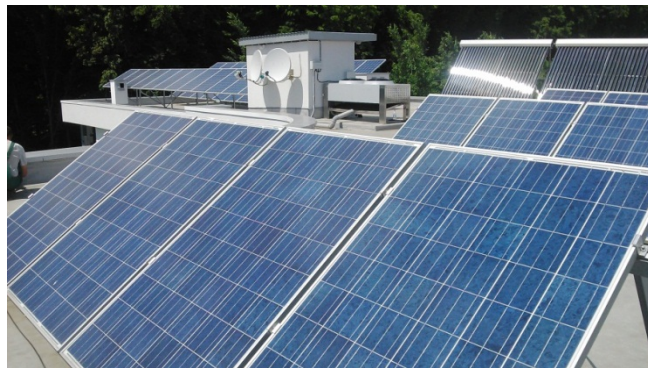
Рис. 4. Сонячна електростанція потужністю 12 кВт (м. Хмельницький)
